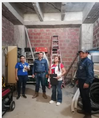
Revisión de la bodega, Filtraciones de agua
