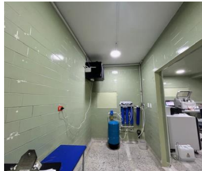
Adecuación en el área de laboratorio clínico
