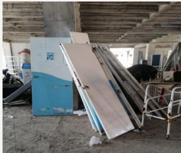
Puertas desinstaladas de las habitaciones o cultorios
