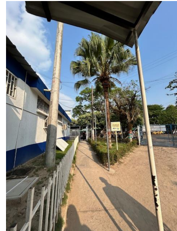
Adecuación del ingreso de peatones
