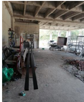
Zona de Pintura
