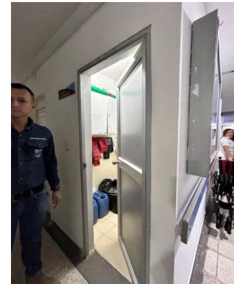
Cambio de puerta del cuarto de servicios básicos urgencia y baño
