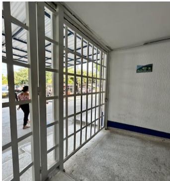
Se pintó fallada , Puerta y Cambio de Techo entrada urgencias
