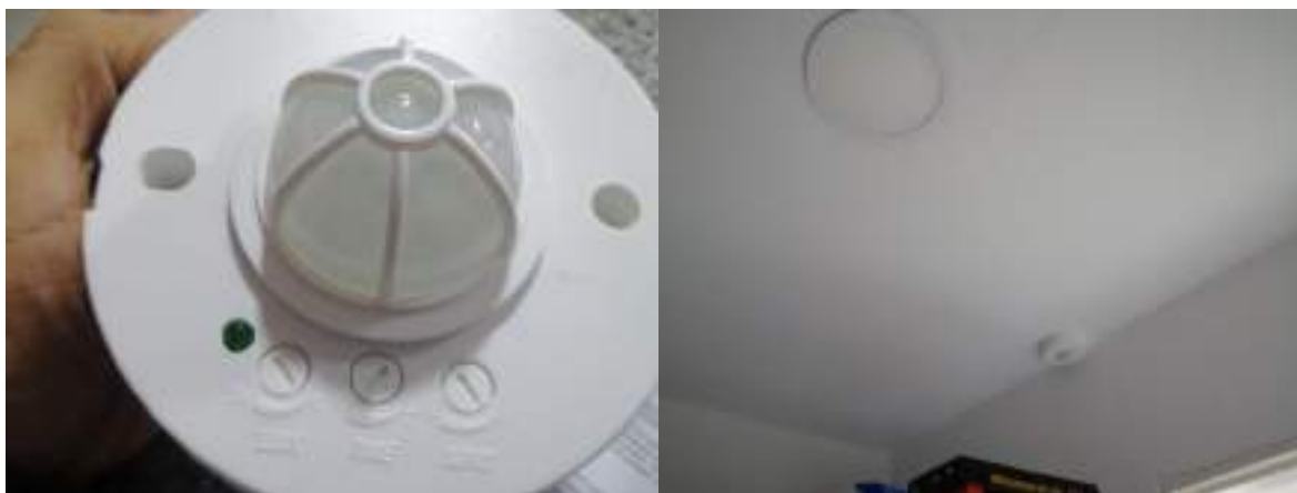
Instalación de sensores de movimiento
